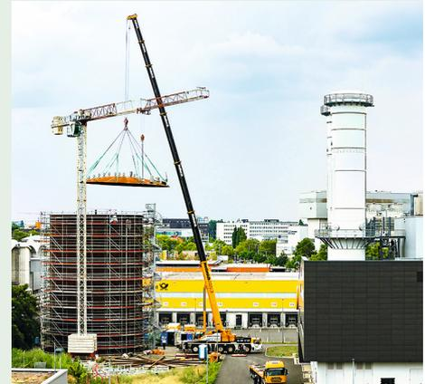
Ein wichtiger Meilenstein war im Jahr 2019 der Bau eines vier Millionen Liter Wasser fassenden Wärmespeichers. Darin kann überschüssige Energie aus der Müllverbrennung gespeichert und bei Bedarf ins Netz eingespeist werden.
